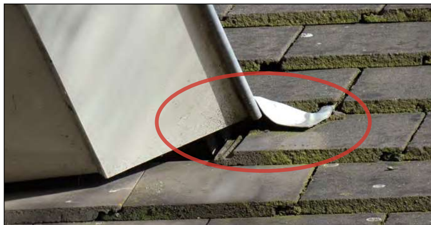
Figuur: onder het lood op het dak van de apotheek is ruimte waar huismus kan nestelen en vleermuizen verblijfplaatsen kunnen hebben.
