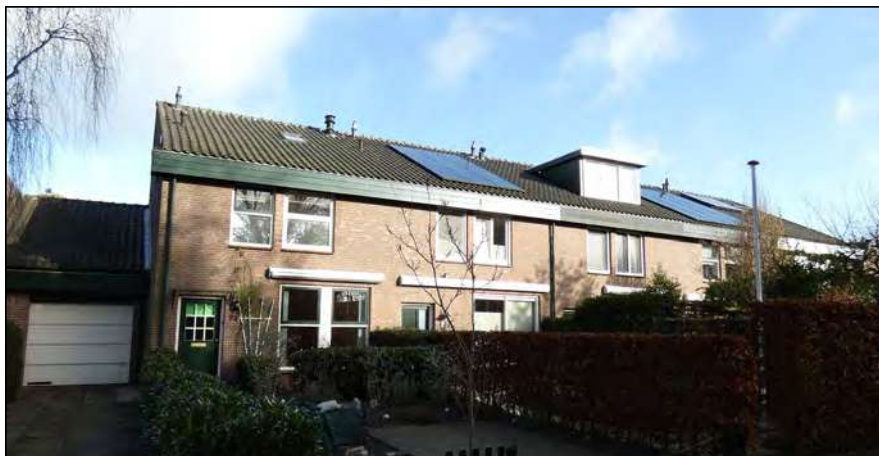
Figuur: ten (zuid)oosten van het plangebied staan woningen met dakpannen die geschikt zijn voor huismus, gierzwaluw en vleermuizen. Er is ruimte onder dakpannen aanwezig.
