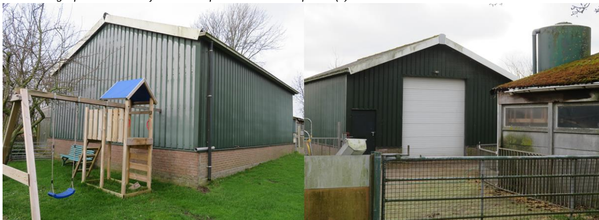
Fig. 7: Mogelijk te slopen schuur (2)
