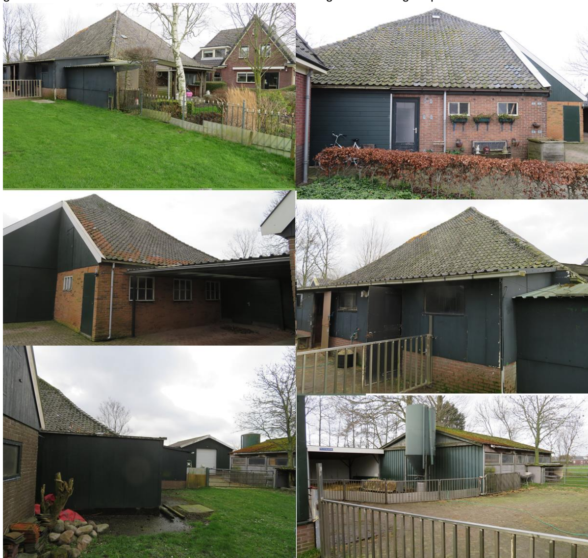
Fig. 6: Vlnr: zijaanzicht boerderij, vooraanzicht boerderij, zijaanzicht boerderij, achteraanzicht boerderij en rechtsonder te slopen schuur met golfplaten dak en zijkanten van plaatstaal en betonplaten (1).
