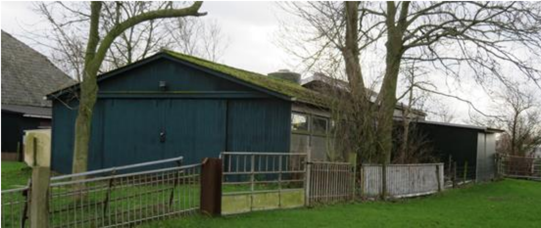
Fig. 9: Te slopen schuur (1) met dak van golfplaten.
