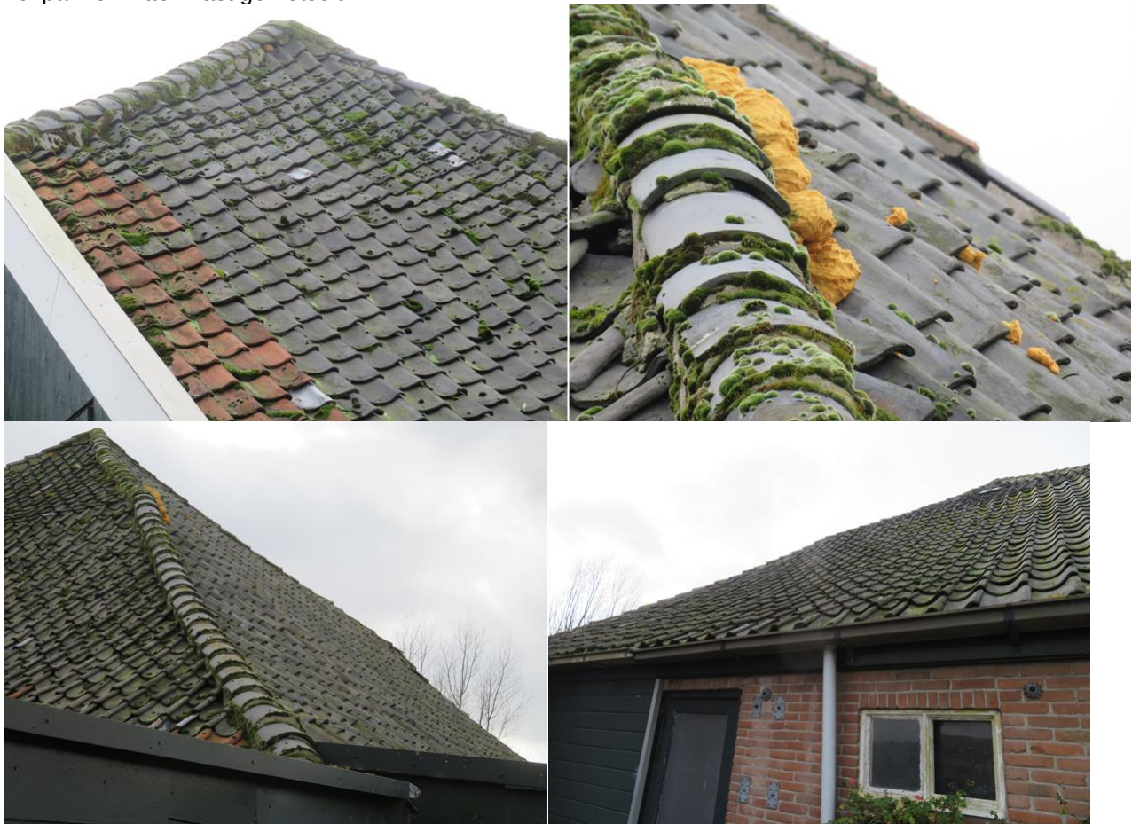
Fig. 8: Detailfoto's van goed sluitende pannen op het dak in het plangebied.
