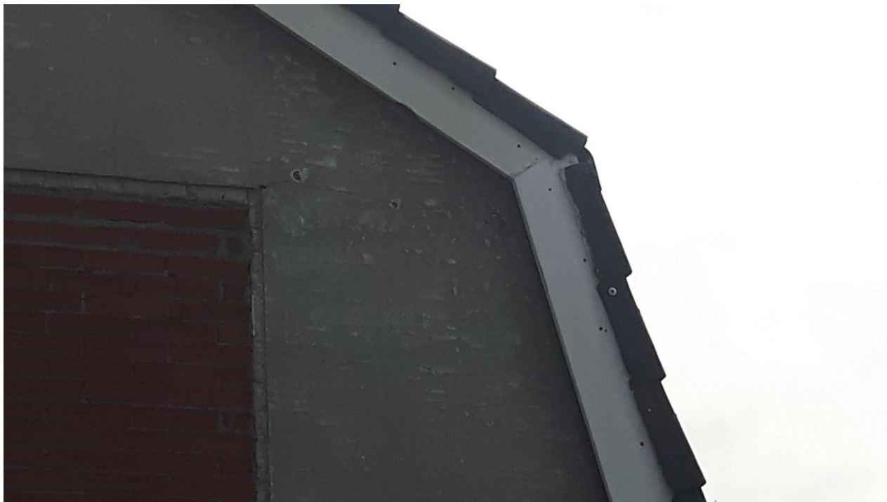
Achtergevel 124: geen ruimte tussen dak en muur
