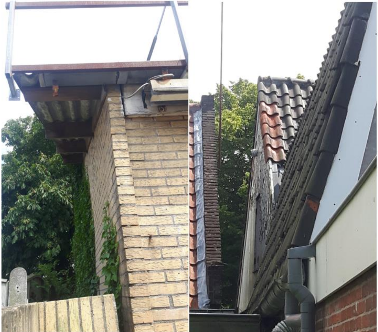
Links: de achtergevel van de loods is met klimop begroeit, vogels kunnen in de boom en in de klimop broeden. Rechts: ruimte tussen 124 en 126. Bij 124 missen de laatste dakpannen. Deze uitvliegmogelijkheid is voor vleermuizen en gierzwaluw ongeschikt, omdat beide soorten zich ruim 2 meter laten vallen uit het verblijf. Op de foto is te zien dat alle pannen goed aansluiten.
