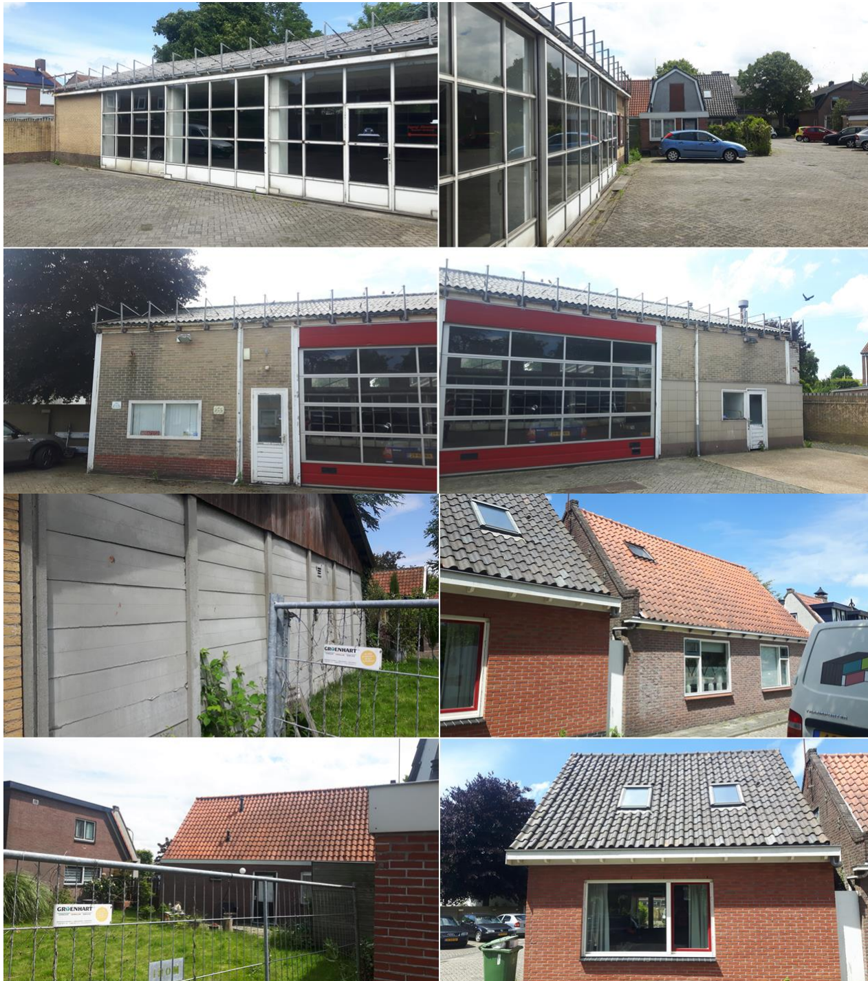
Foto-impressie plangebied: witte loods en rode loods. Zijkant loods en gazon. Woonhuizen, voor- en achterzijde.
