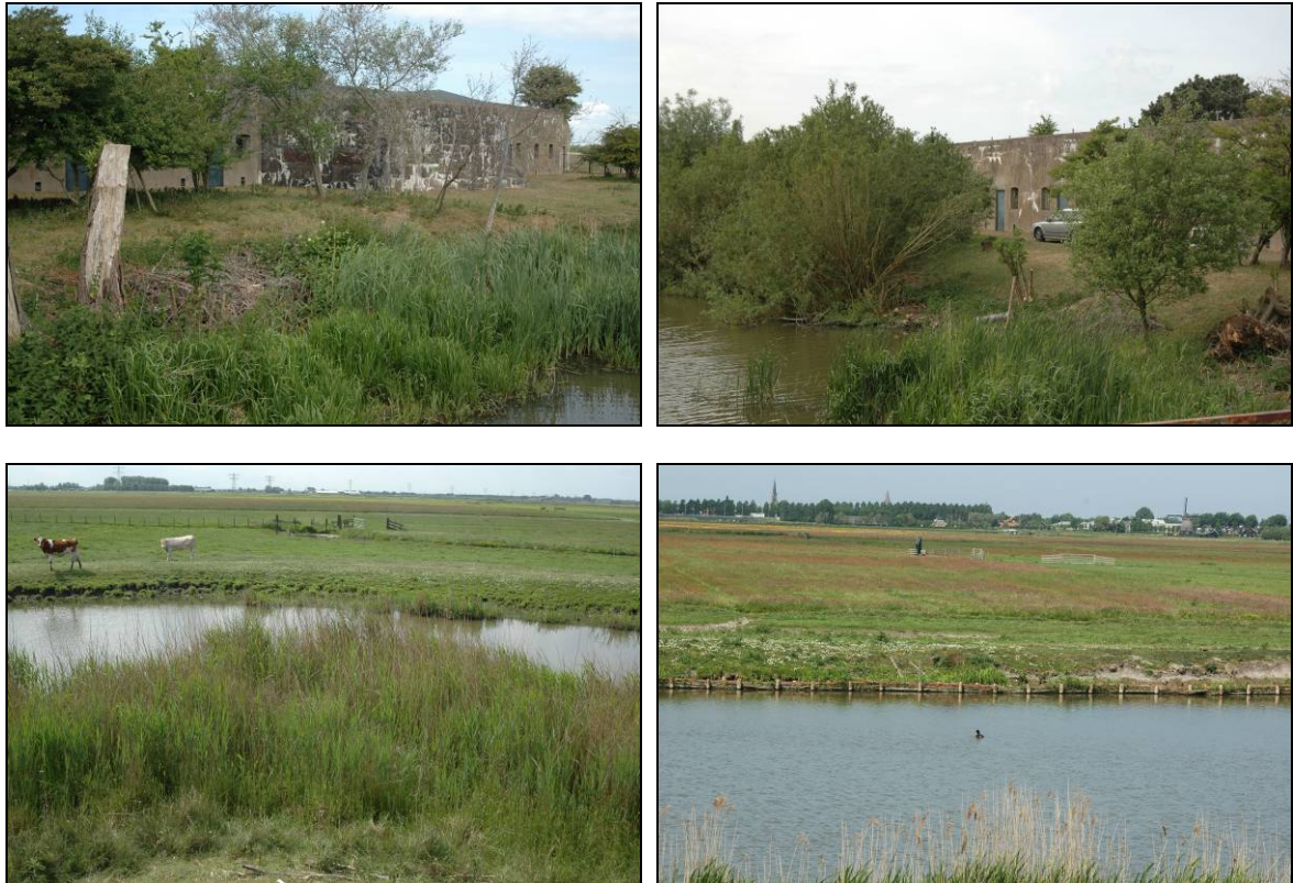
Figuur 2. Foto-impressie van Fort Krommeniedijk.
