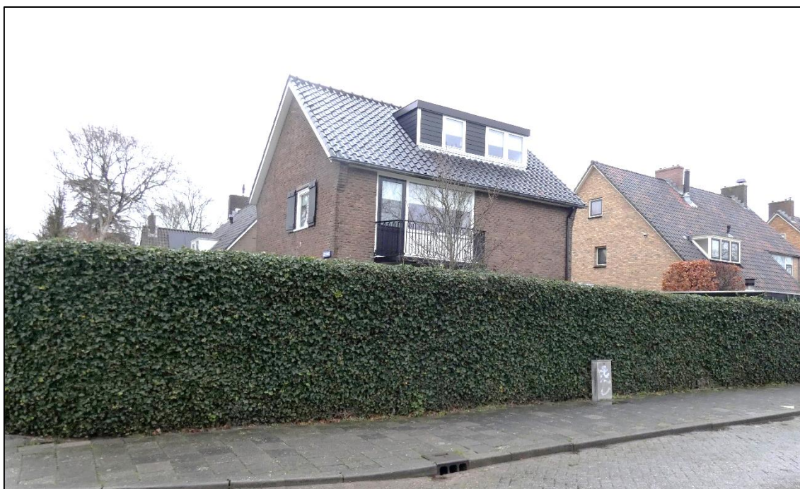
Figuur 8: De woningen grenzend aan het plangebied beschikken over geschikte dakpannen voor de huismus en functioneel leefgebied in de vorm van een groenblijvende klimophaag.
