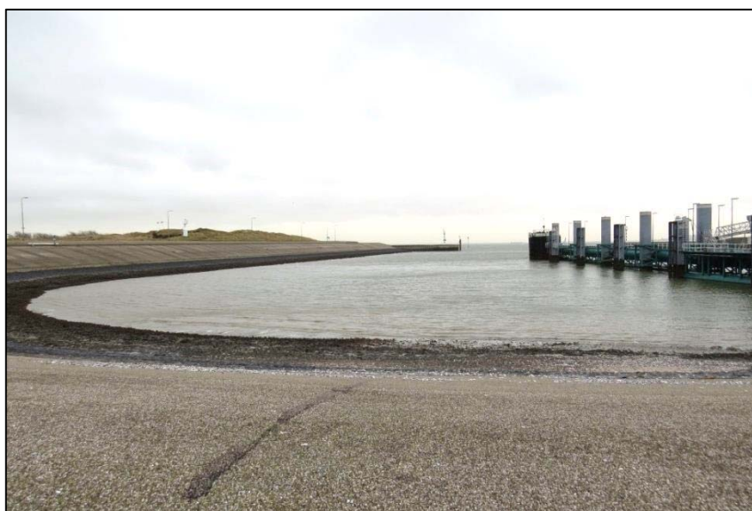
NO-hoek van de Veerhaven Texel, de locatie die gebaggerd gaat worden ten behoeve van de derde ligplaats.
