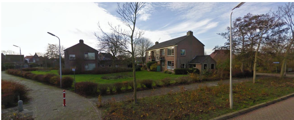
Figuur 4. Aanzicht op het perceel vanaf de Mulderstraat (bron: Google Street-view)
