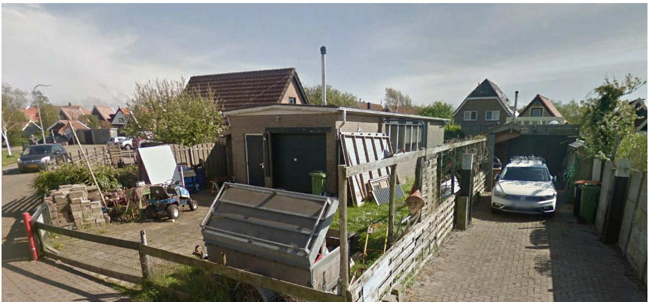
afb. 3 De huidige situatie op het perceel Trompstraat 77
