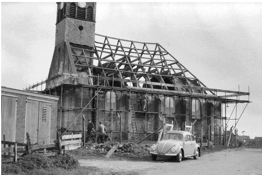
Afbeelding 1. Een blik in de Trompstraat tijdens de restauratie van de Zeemanskerk.
