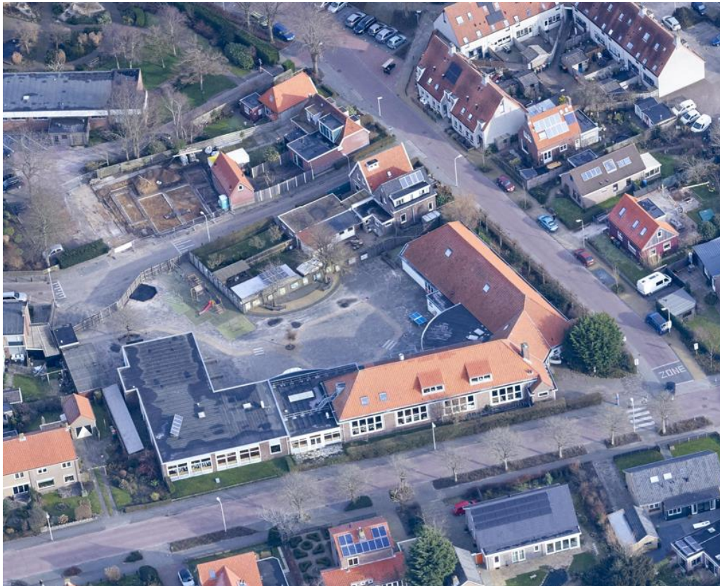
Afbeelding 1 Luchtfoto van de locatie Jozefschool
