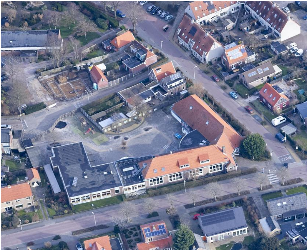
Afbeelding 1 Luchtfoto van de locatie Jozefschool
