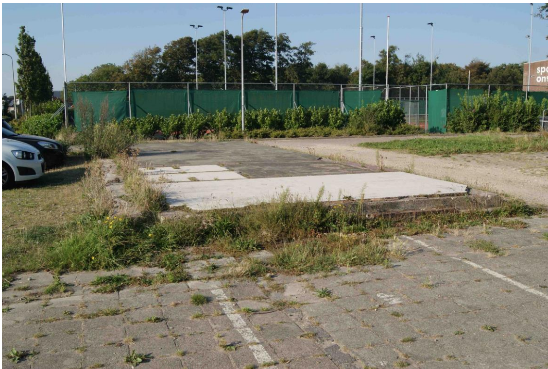
Afb 7 Betonfunderingen van afgebroken gebouwen bevinden zich nog in de bodem. zomer 2016
