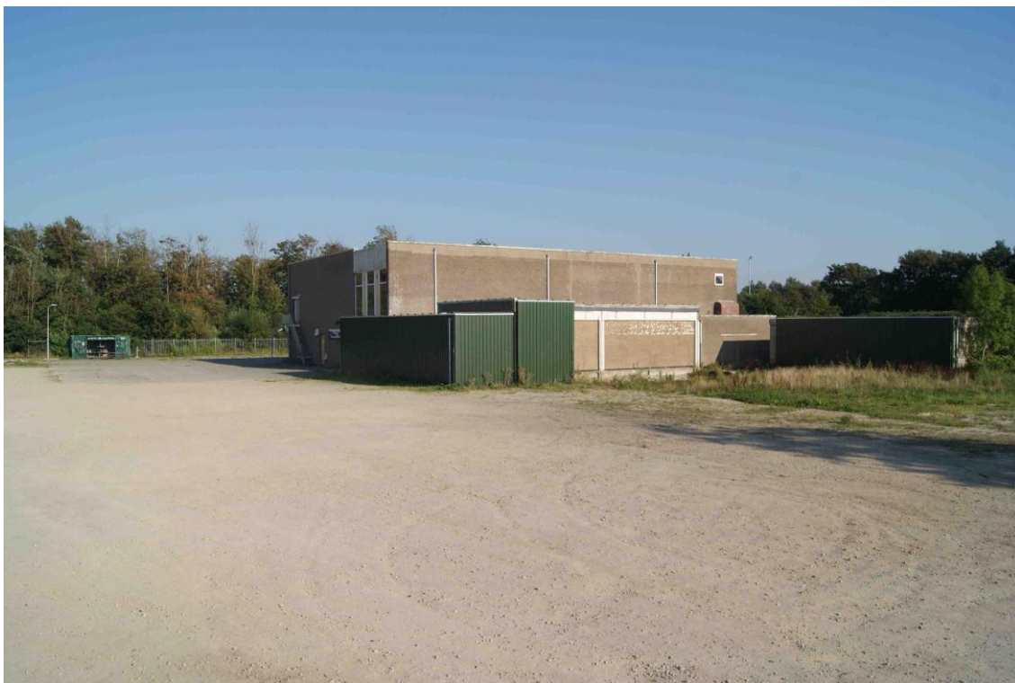
Afb 8. De puinverharding van het opstelterrein met rechts kuilen van de diepsloop van voormalige opstallen en in het midden de sporthal de Koningshal. Op de locatie van de puinverharding lagen destijds gravelbanen.
