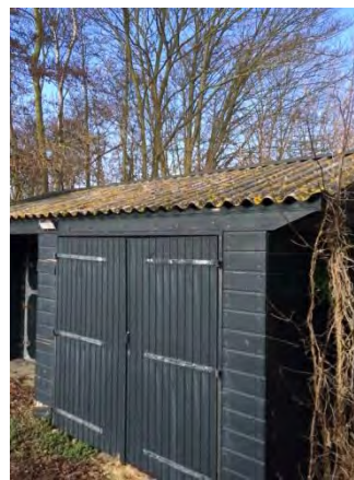
Figuur 7: Overzichtsfoto bebouwing
