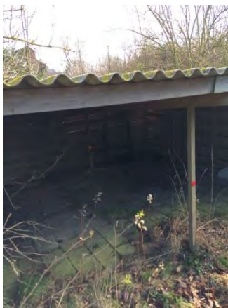
Figuur 6: Overzichtsfoto bebouwing
