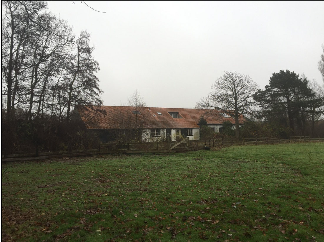
Afbeelding 9. Plangebied, bebouwing en deel zuidelijke perceel.
