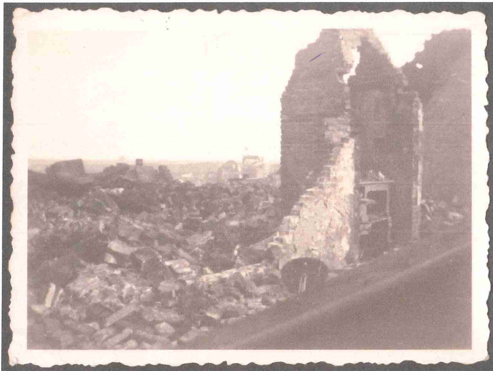
Hoeve Schiller was na de brand een ruïne. Op de voorgrond de kelderingang in het woonhuis.
