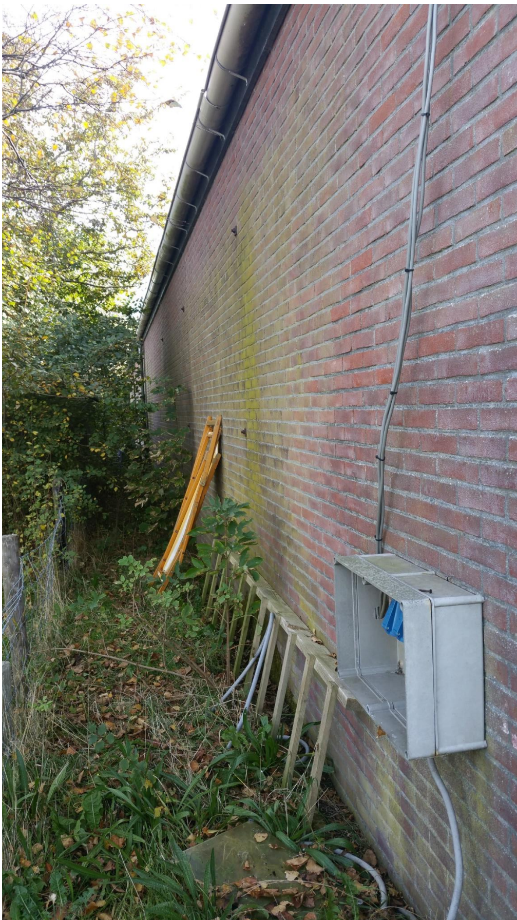
Figuur 5. Zijgevel zonder openingen
