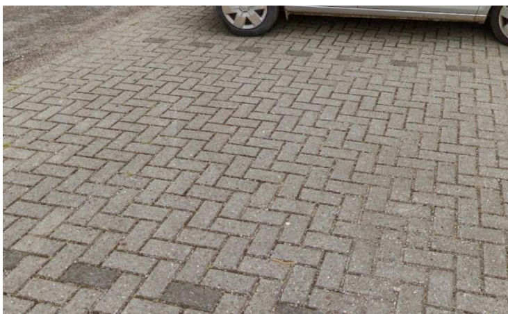
Figuur 8: Aangelegde halfverharding t.b.v. de parkeerstrook aan de Akenbuurt 14 (Bron: Google Maps)
