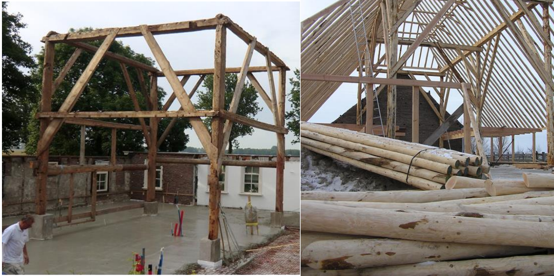
Primaire (links) en secundaire (rechts) stolpconstructie
