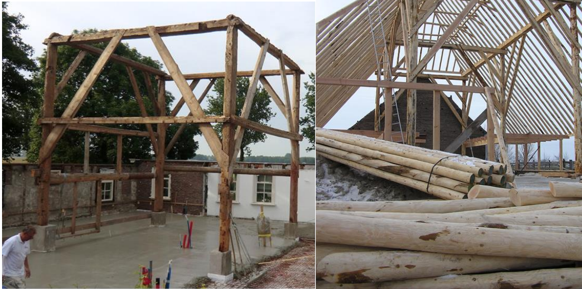
Primaire (links) en secundaire (rechts) stolpconstructie
