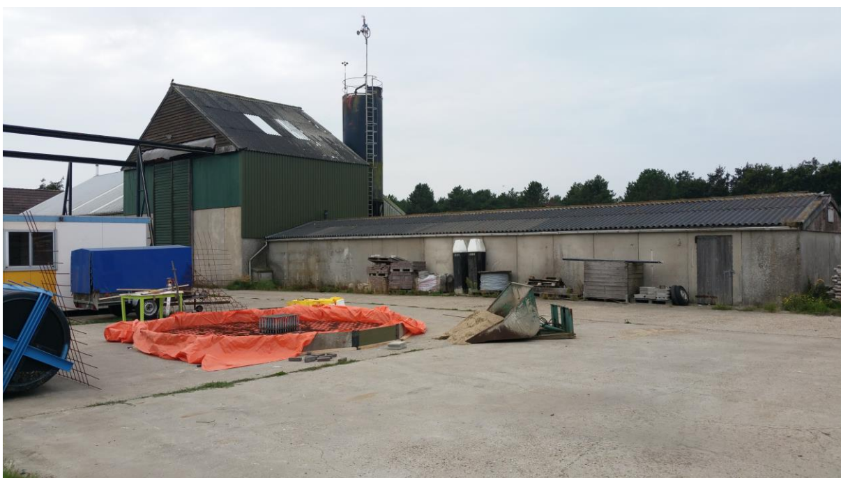
Figuur 7. Te slopen schuren
