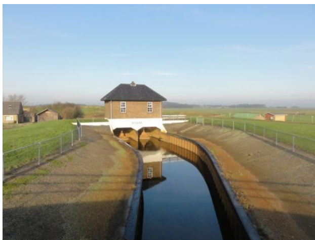
Afbeelding 2.1 Gemaal De Schans
