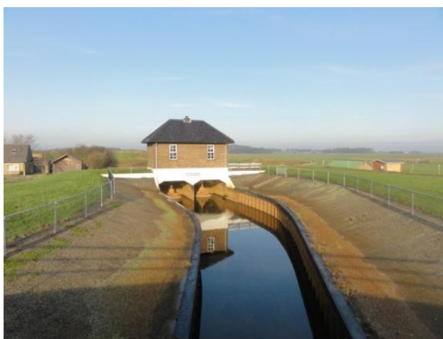
Afbeelding 2.1 Gemaal De Schans
