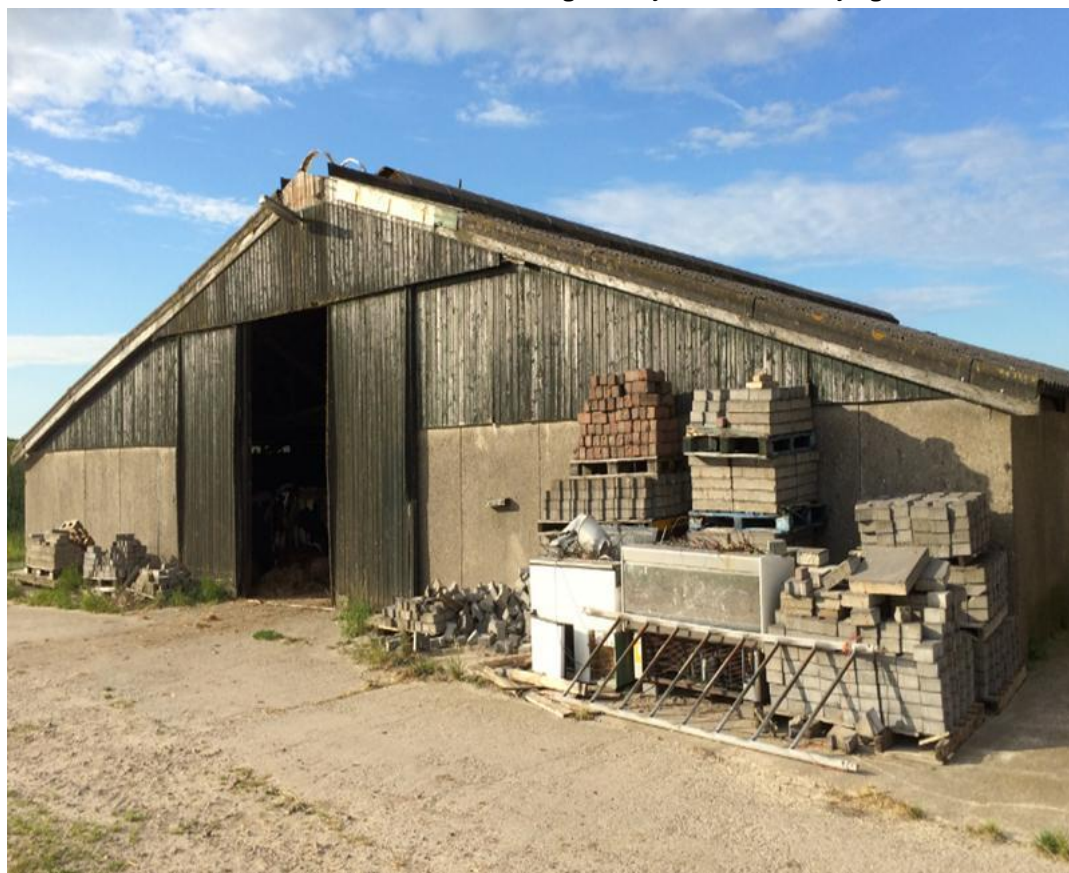
Foto impressie exterieur te slopen jongveestall
