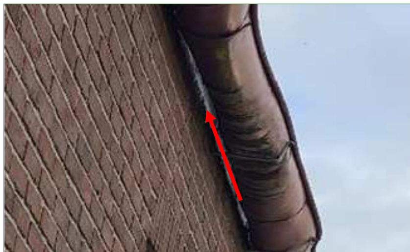
De openingen onder de dakgoten (rode pijl) van de bebouwing geven mogelijk toegang tot voor Gierzwaluwen geschikte achterliggende ruimtes.
