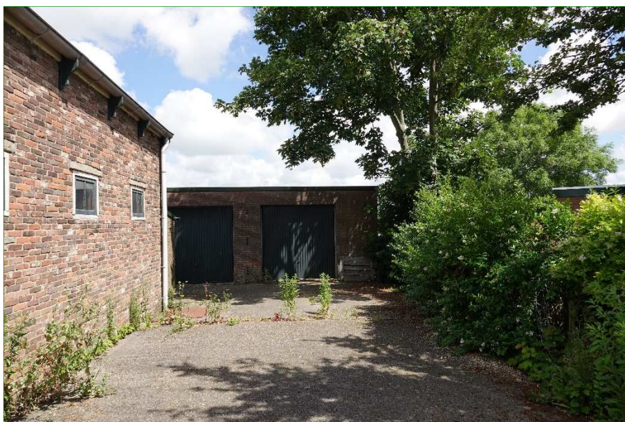
Betonnen verharding aan de oostzijde van de schuur.
