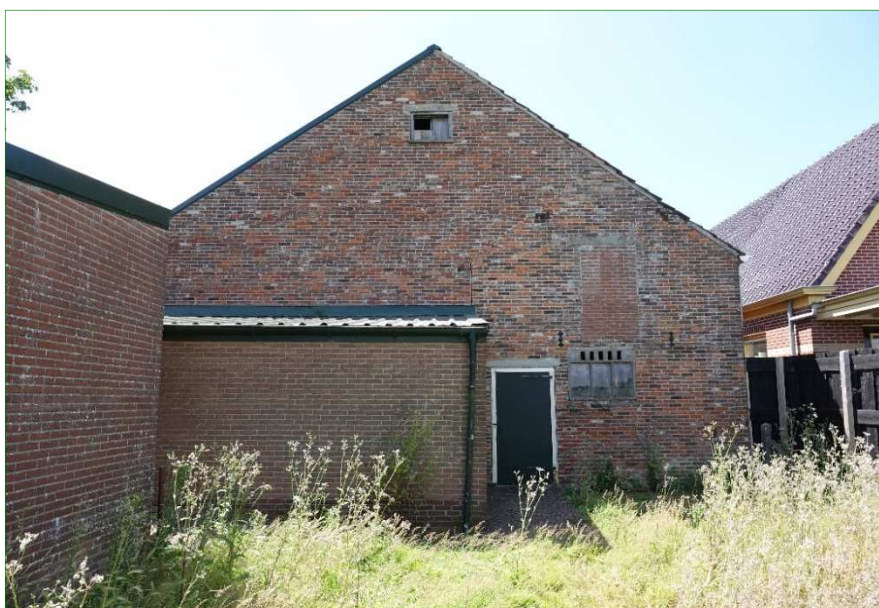
Aan de achterzijde van de schuur zijn een raam en enkele openingen boven een raam zichtbaar.
