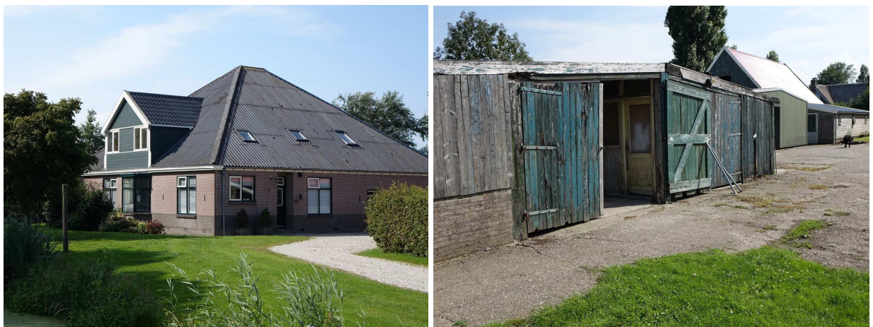
Figuur 2. De te restaureren stolp (links) en achterliggende bijgebouwen (rechts)
