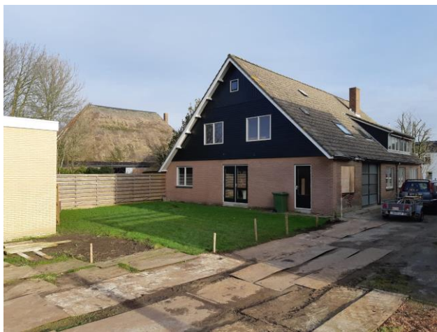
Figuur 6: Aangezicht op het bedrijfspand vanaf de achterzijde van het terrein
