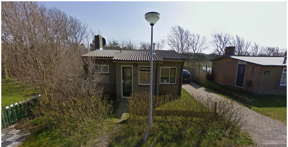
figuur: foto bestaande toestand
