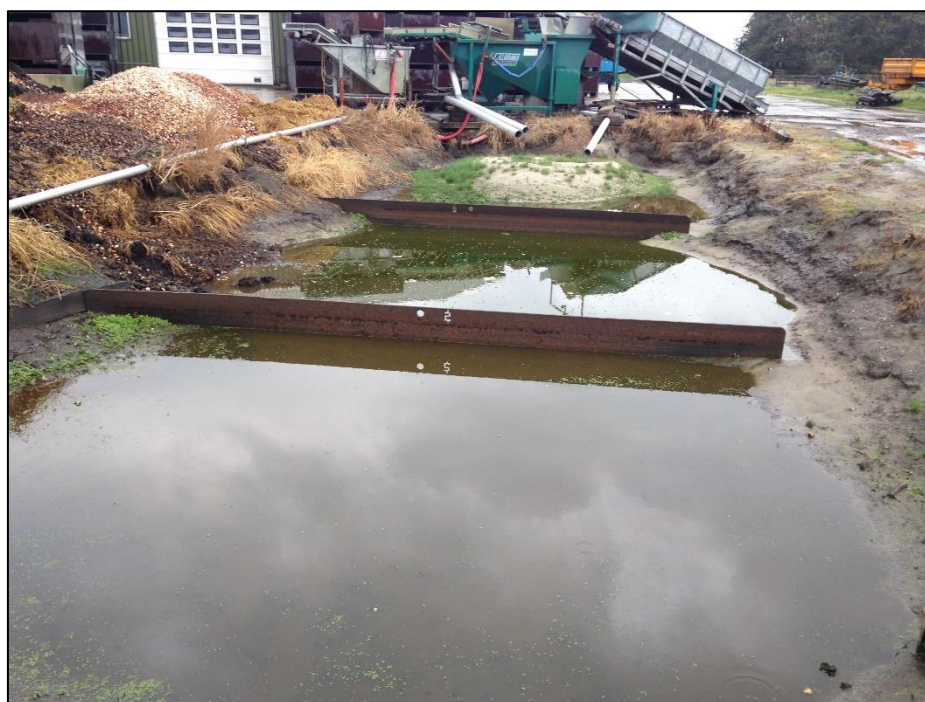
Foto 2. Detailfoto van de spoelput aan de zuidoostzijde van het plangebied.
