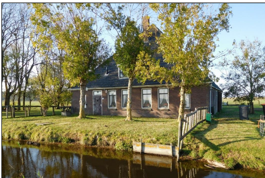
Figuur 2. Huidige bebouwing Korte Bosweg 53 't Zand
