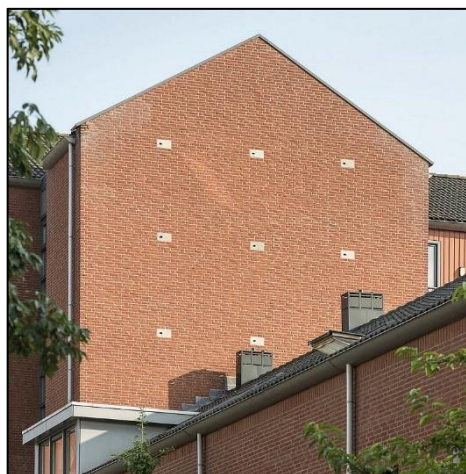
Afb 21 + 22: Gierzwaluwkasten ingemetseld (worden ook gebruikt door Huismussen)
