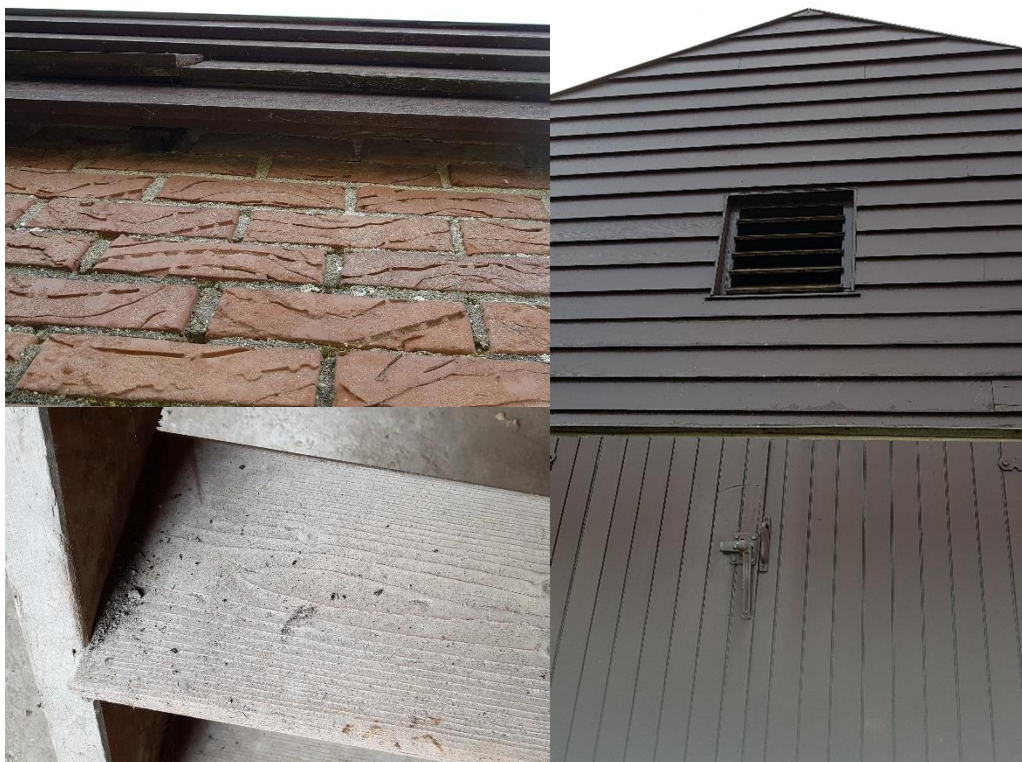
Figuur 11. Sporen/aanwijzingen van vleermuizen in gebouwen.
