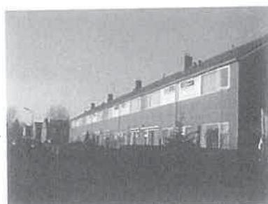
Projectmatige bouw in Groeneweg
