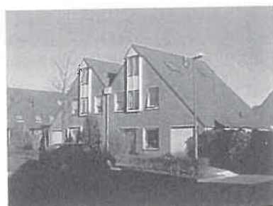
Projectmatige bouw in Muggenburg
