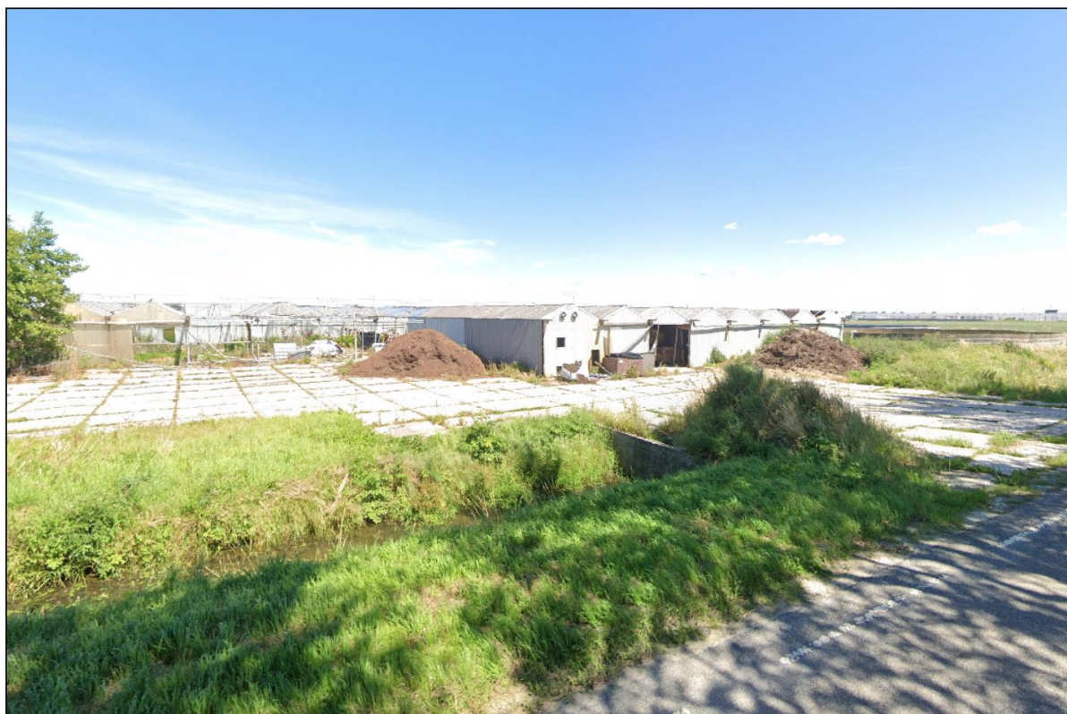
Afbeelding 2.3 Straatbeeld kassencomplex Trambaan nr. 30 (Bron: Google maps, 2022)
