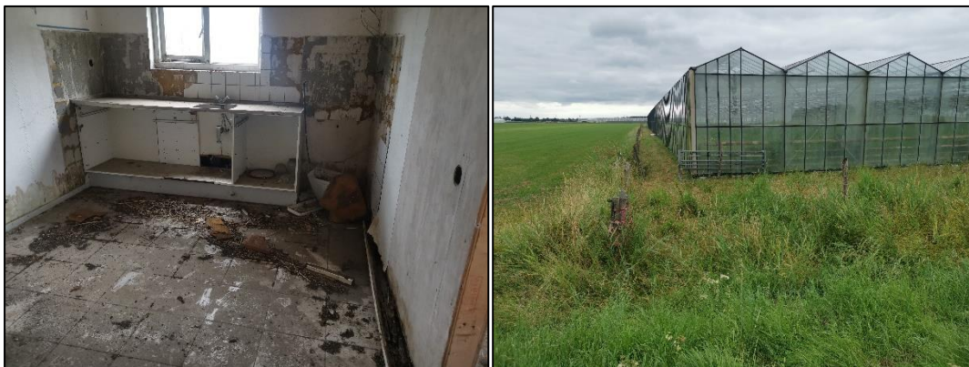
Figuur 2.8 (links): Binnenaanzicht van de bij ruimte van de kas; Figuur 2.9 (rechts): Impressie van de kas, gezien vanaf de noordwestelijke zijde. De groenstrook langs een deel van de kas wordt begrast door schapen.
