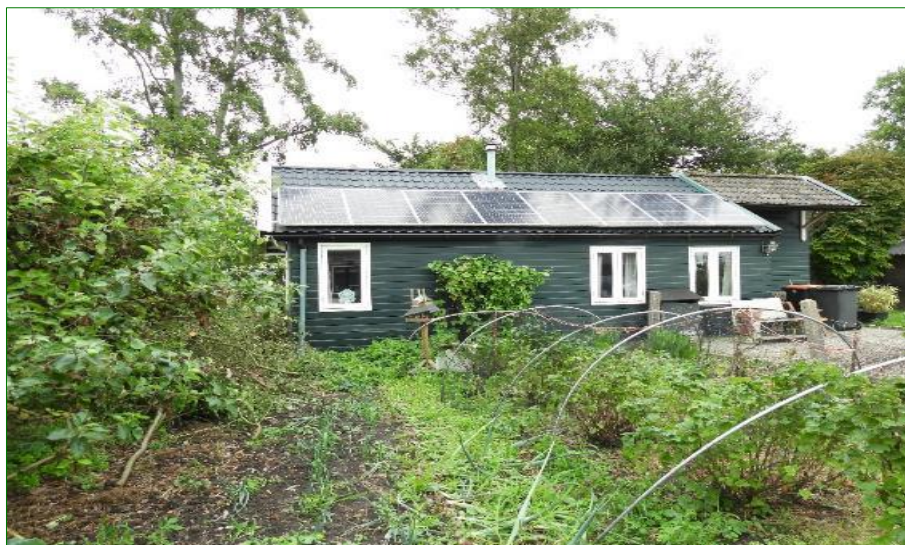
De bestaande te slopen woning binnen het plangebied.
