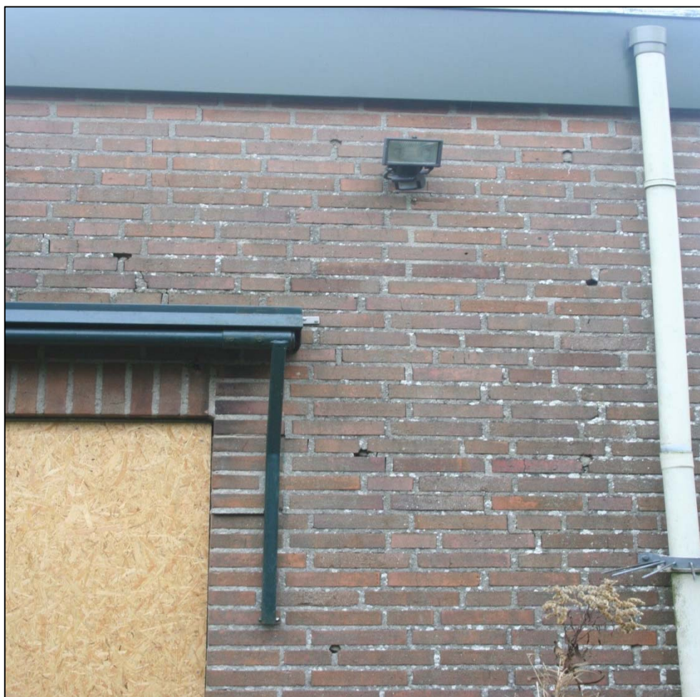
Gaten tussen de voegen werden niet gebruikt door vleermuizen.
