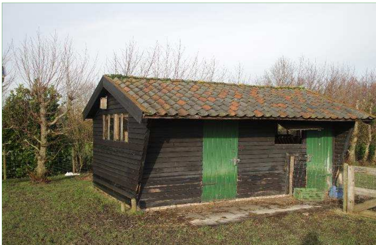
De te slopen schuur aan de noordwestzijde van het plangebied.
