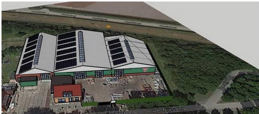
Figuur 3: De bestaande bedrijfshallen van EMT
