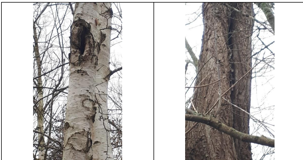
Afbeelding 7: Potentiele verblijfplaatsen van boombewonende soorten vleermuizen (Aveco de Bondt, 2019).
