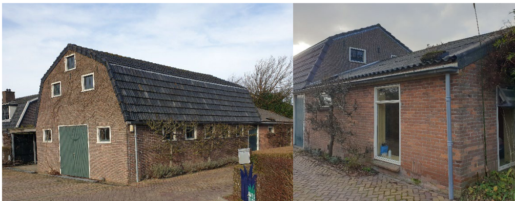
Figuur 5 Bestaande schuur met aanbouw, wordt gesloopt
