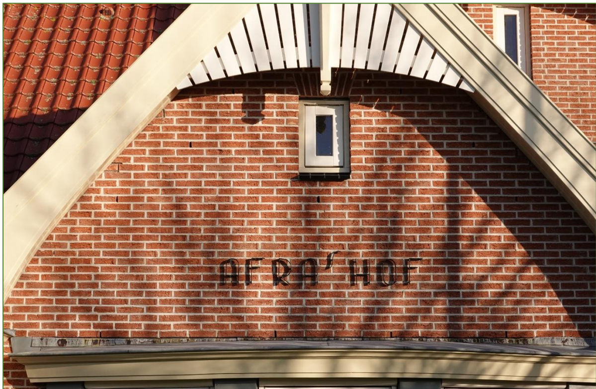
Figuur 8 Open stootvoegen in een muur aan de zuidzijde van het gebouw.
