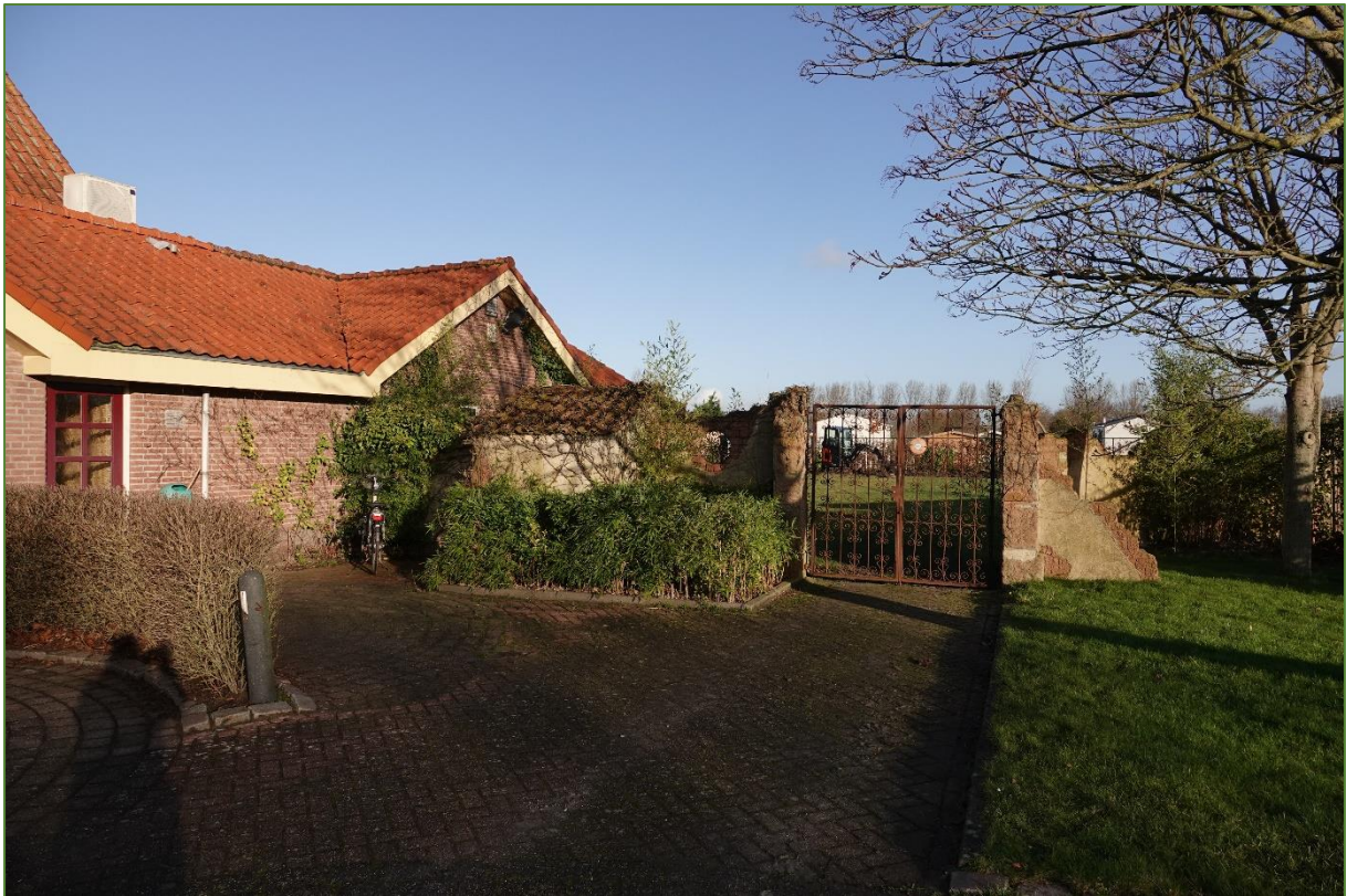
Figuur 4 Oprijlaan gelegen tussen het entreegebouw en de voormalige tennisbaan.
