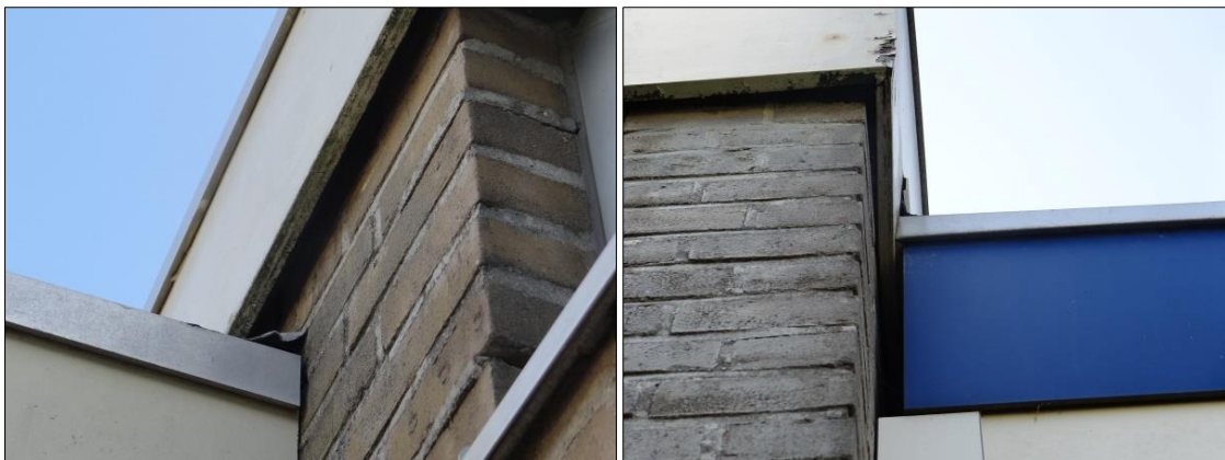
Foto's 9 en 10. Openingen en ruimtes bij de dakranden en aansluitingen die geschikt zijn voor vleermuizen
