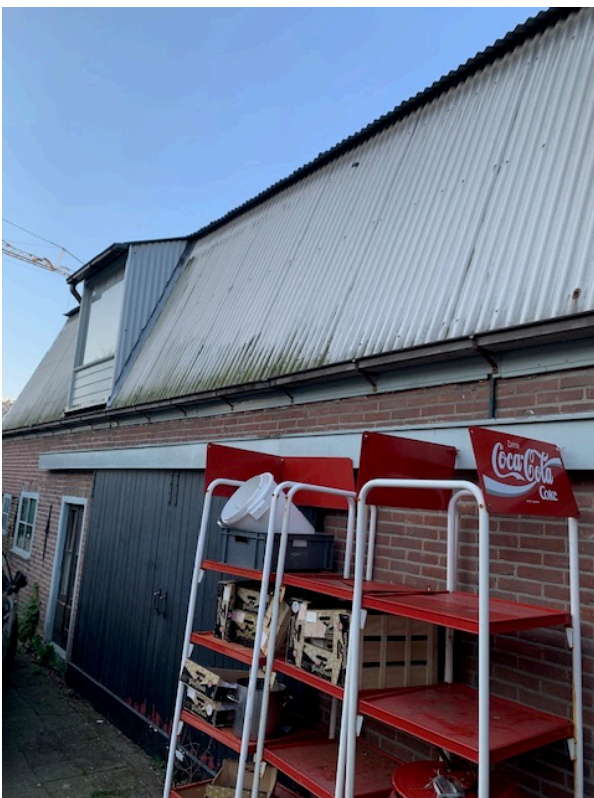
Figuur 7 Grote schuur met golfplaten dak
