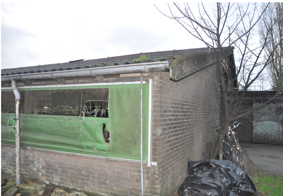
één van de opstallen die zal worden gesloopt.
