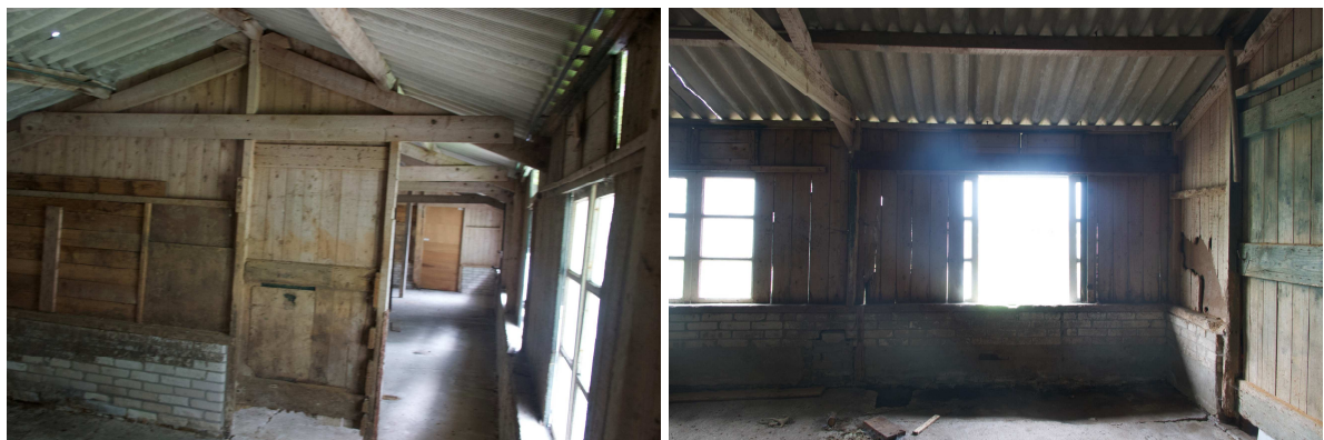
Figuur 4. Interne inspectie van de voormalige kippenschuren.
