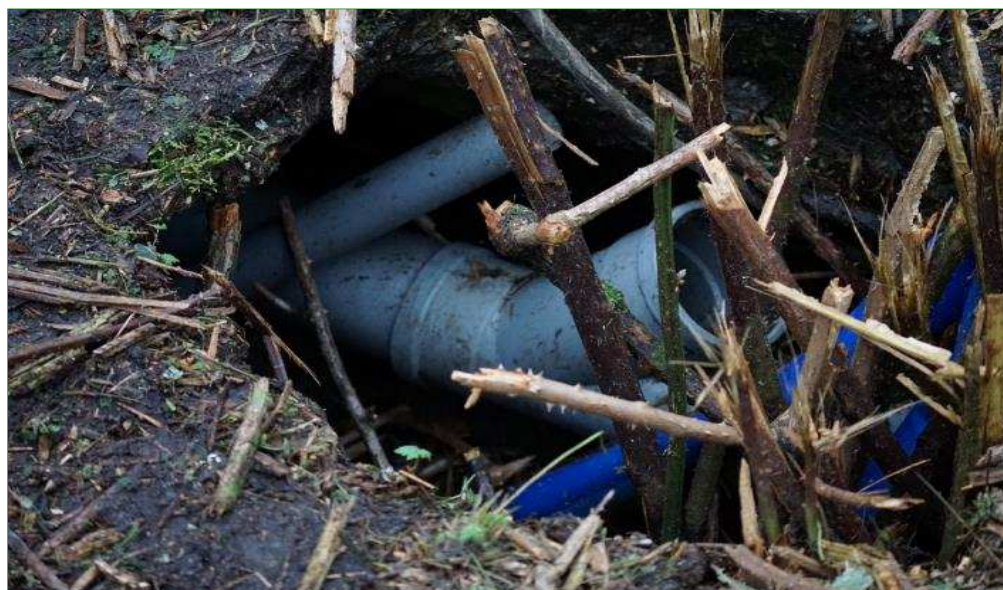
Gat in de bodem met grijze en blauwe buizen.
