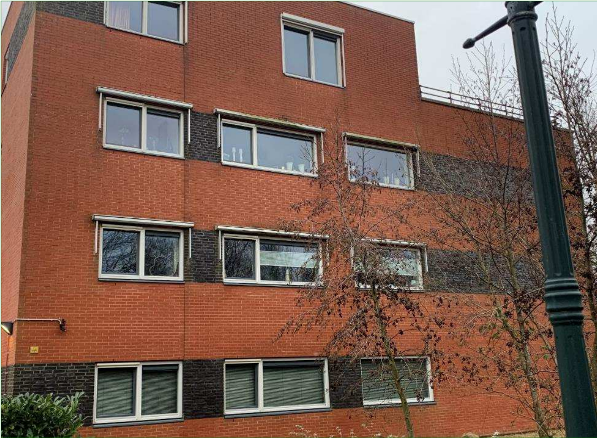
De westgevel van de bebouwing ten oosten van het plangebied waar potentie voor verblijfplaatsen van vleermuizen aanwezig is in onder andere de aanwezige spouwgoten.
