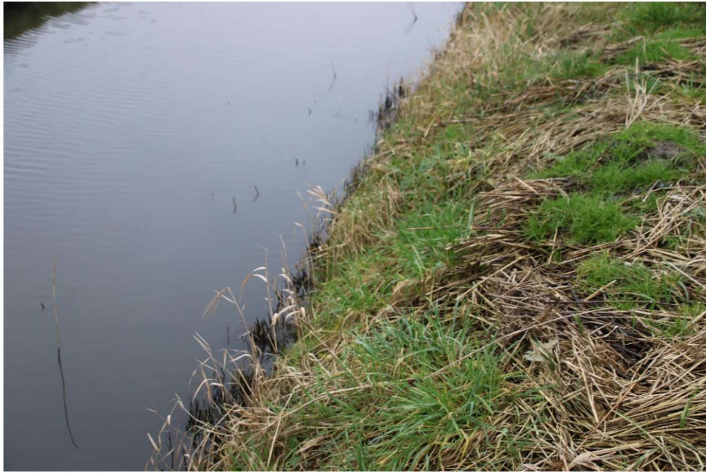
Steile, dichtbegroeide oever te verbreden sloot
