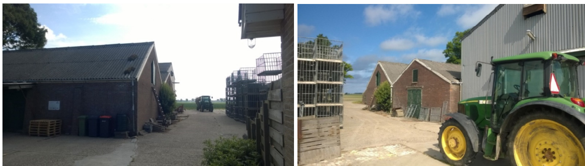
Foto's; Aanzicht bestaande schurencomplex bestaande uit 3 grote schuren en een stallingsruimte (bijna allen voorzien van asbest dakbedekking)
