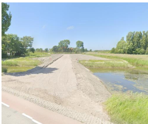
Uitrit met toegangsweg oostzijde
